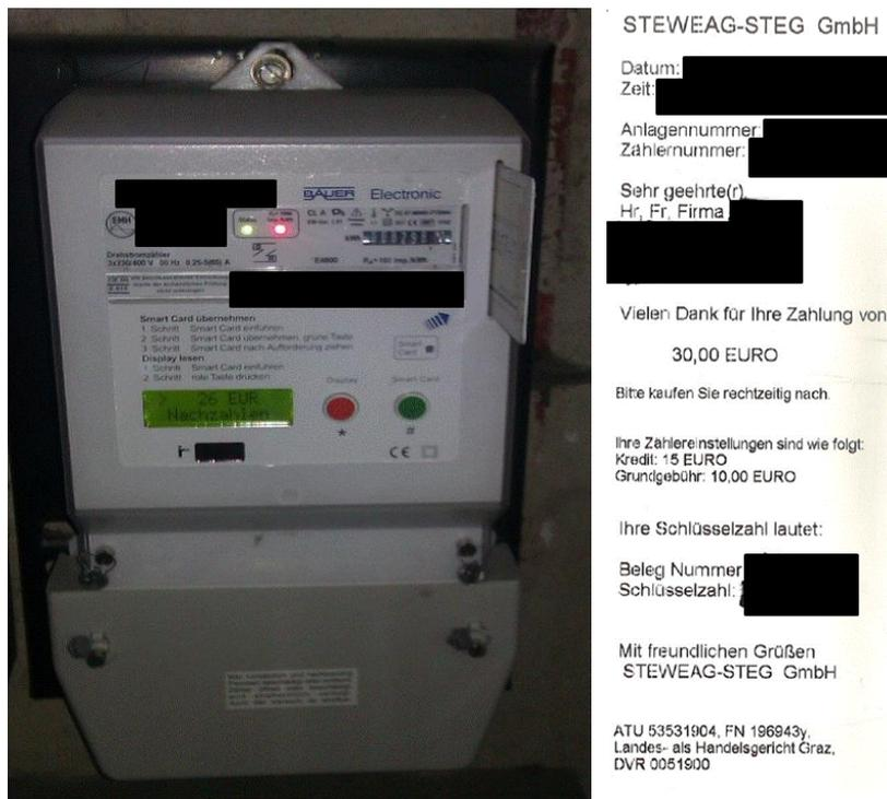
**Abb. 21: Prepayment-Meter mit eingesteckter Chipkarte (links) sowie ein Scan eines Ladungsbons (personalisierbare Daten durch den Autor geschwärzt)**
