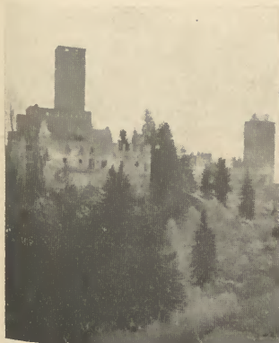
25. Liebenfels, von Norden
